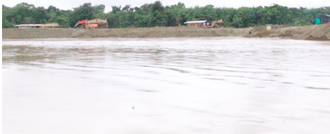
Fotografía 36: Dragas, dragones y retroexcavadoras.
