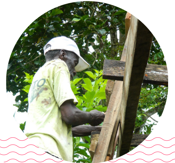
Construcción de vivero en CCL San Martín de Purré, 2018
